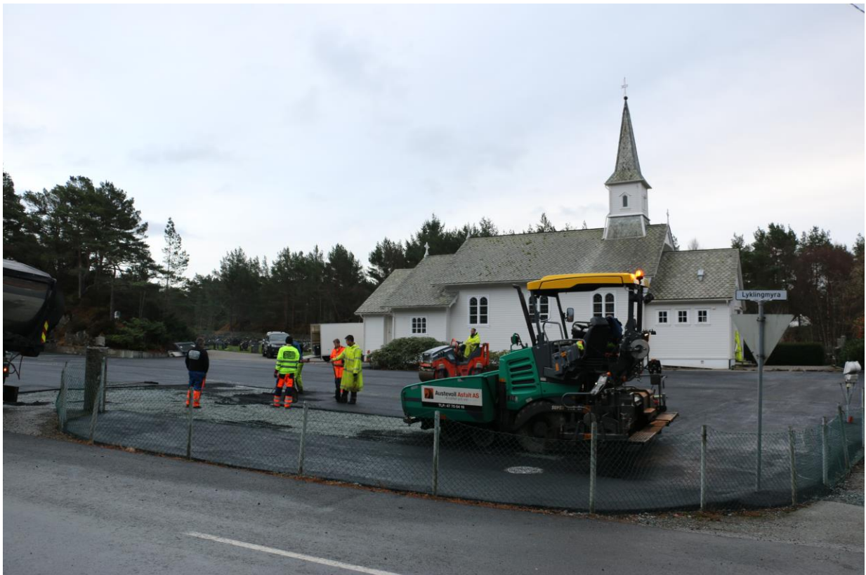
Asfaltering av parkeringsplassen ved Lykling kyrkje. (Foto TL)
